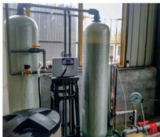
图4-21 一用一备自动控制浮动床软水器
