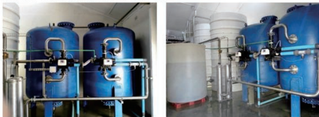
图4-11 过滤-软化串联用水处理系统
