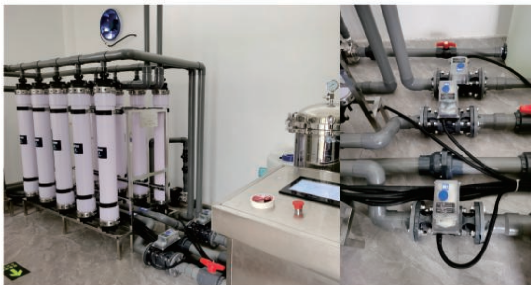
图9-8 球阀应用于农改水系统中
