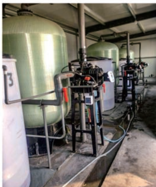
图4-17 软化水处理系统安装图
