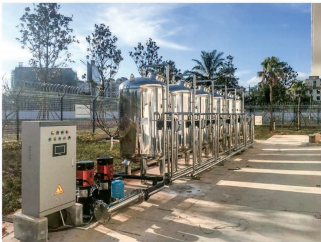
图3-10 控制阀在多级过滤系统中的安装图
