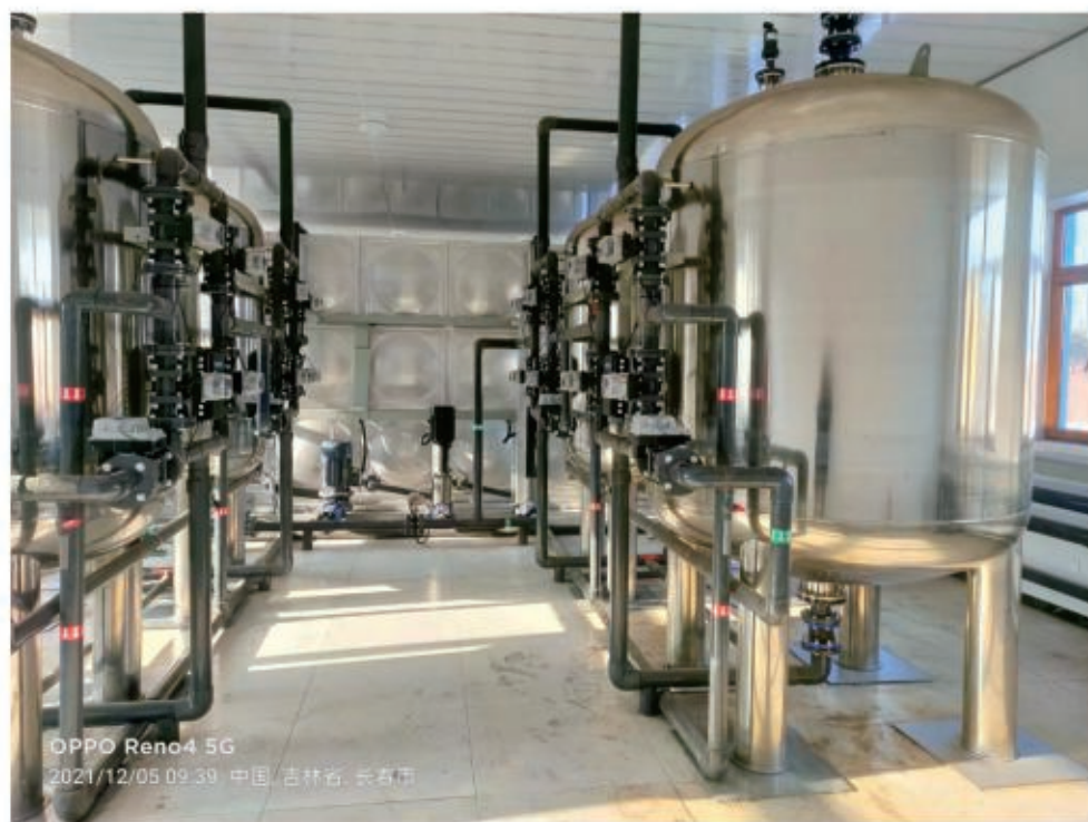
图9-10 球阀应用于同时除铁锰系统
