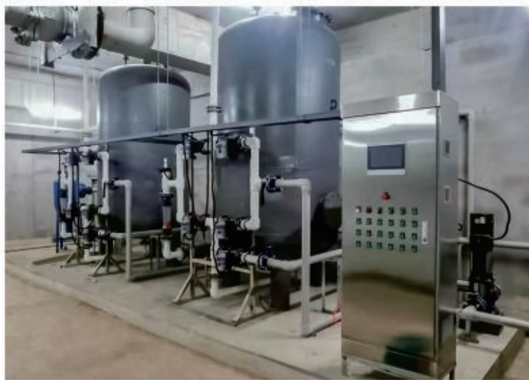
图9-9 球阀应用于含氟温泉水除铁过滤
