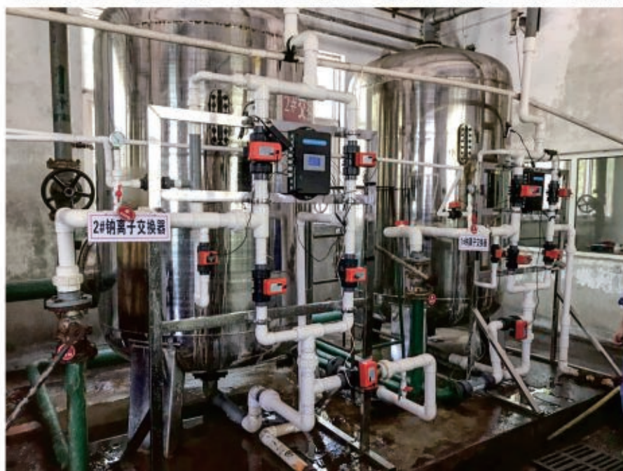
图9-6 球阀应用于软化系统
