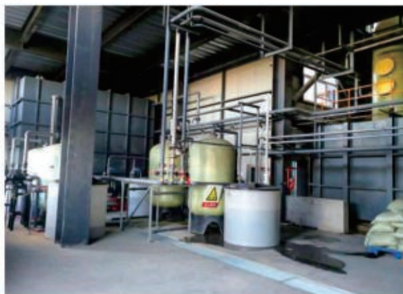
图4-15 氢-钠软化降碱的除炭器及除炭水箱
