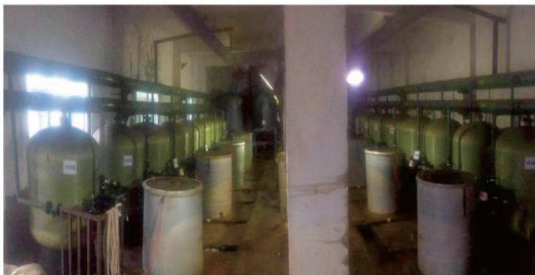
图4-16 八组过滤-软化并联水处理系统
