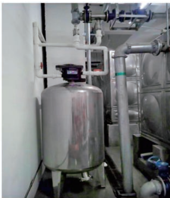
图3-8 过滤器安装图
