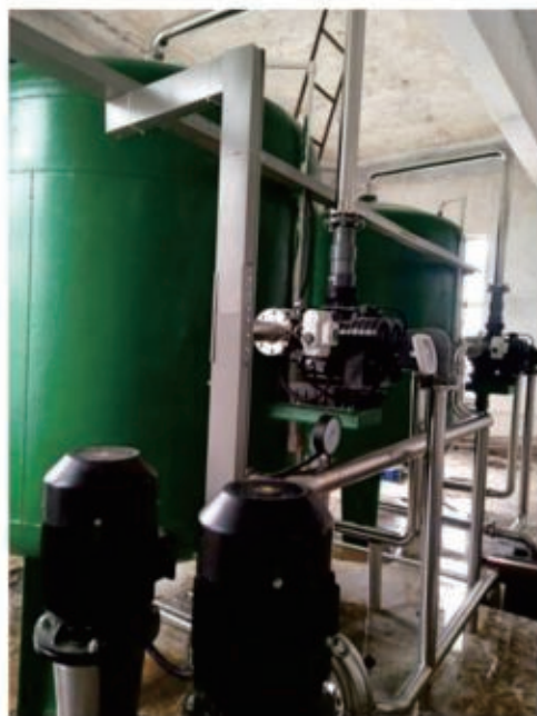
图6-3 除铁锰过滤装置及系统
