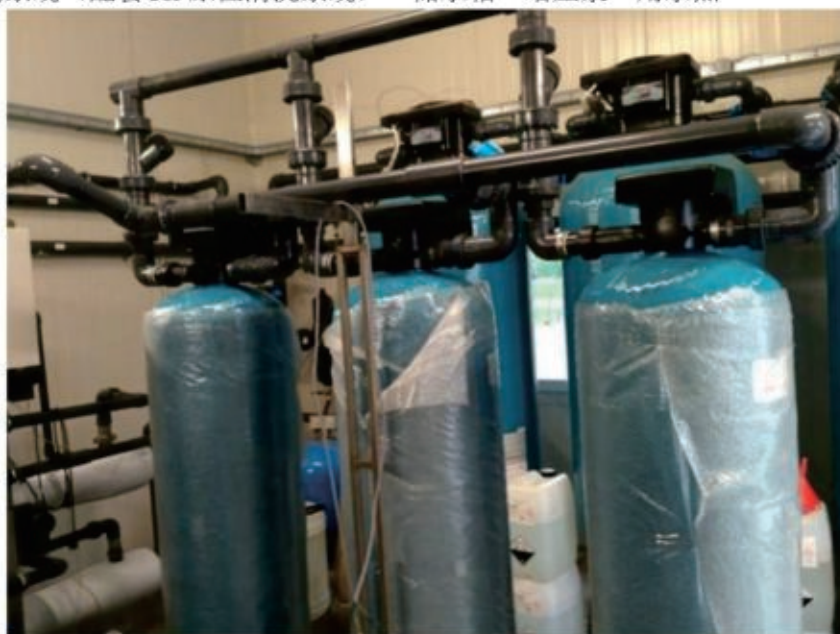
图6-17 除硼系统的设备安装图
