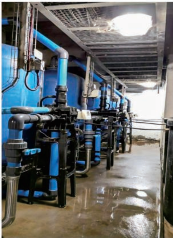
图4-10 并联运行分别再生的软水处理系统
