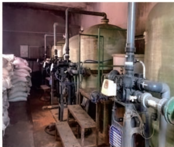
图4-19 四台互锁软水器并联系统
