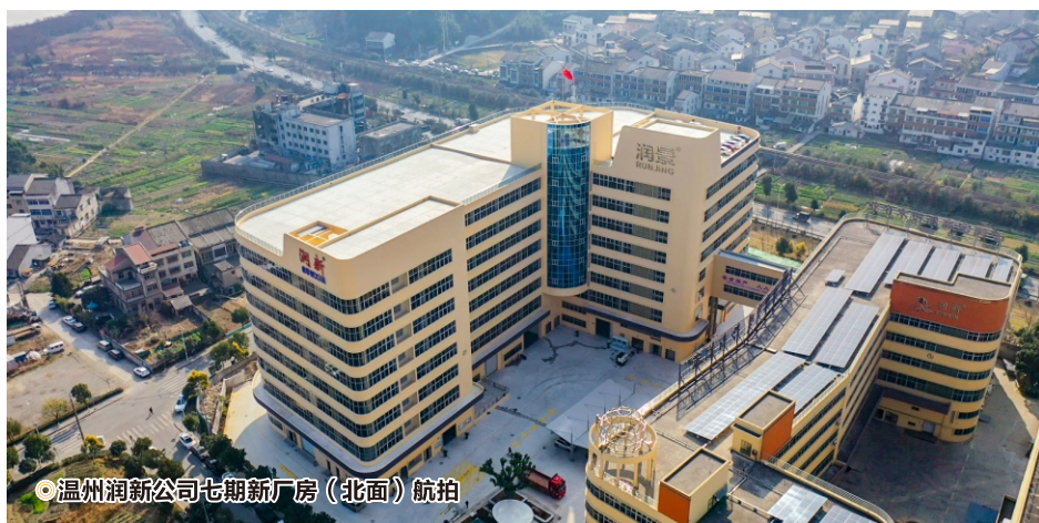
●温州润新公司七期新厂房航拍
