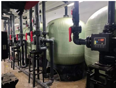
70 \text{m}^3/\text{h} 自动控制阀 F153 应用于智算中心冷却循环水系统
